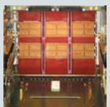
A operação independente das guilhotinas isolantes proporcionam um ambiente seguro quando o disjuntor é removido da cela.
